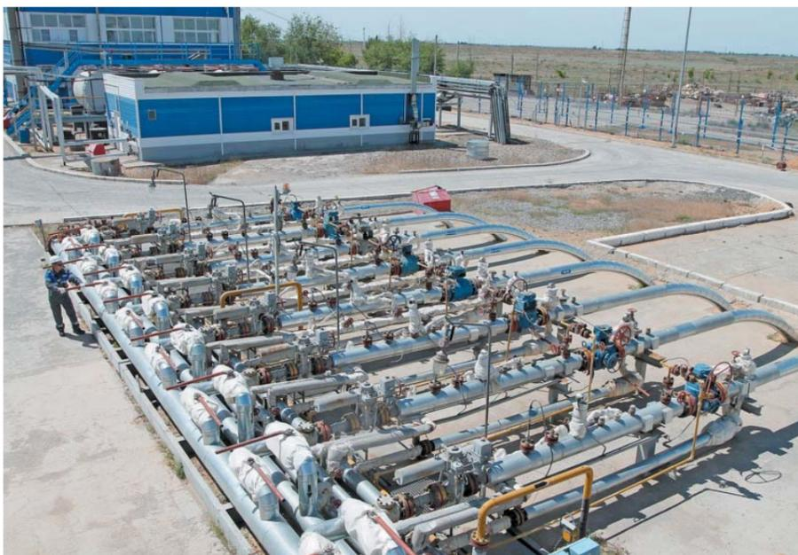
факельное оборудование, насосно-компрессорное оборудование. Техническому диагностированию подвергаются внутрипромышленные трубопроводы, аппараты, контрольные кабели и оборудование автоматизации, осуществляется комплексное электрометрическое обследование подземных трубопроводов.
