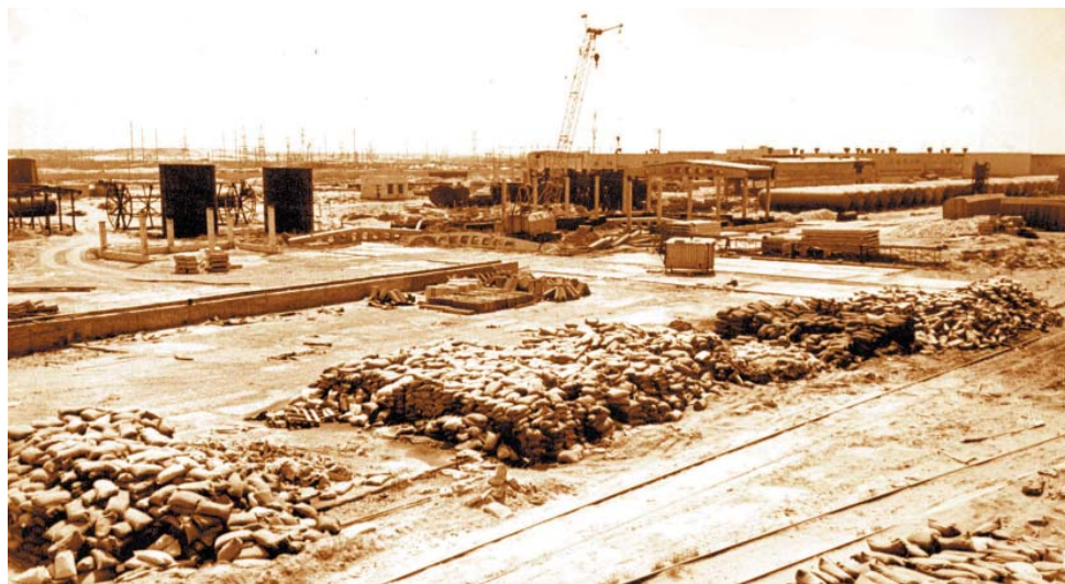
Строительство базы УПТОиК, 1983 г.
