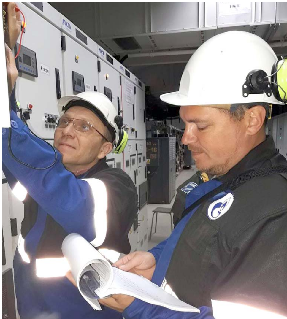
Инженеры А. Егорычев и Ю. Рябкин производят проверку параметров и конфигурации микропроцессорного реле SEPAM серии 1000+
