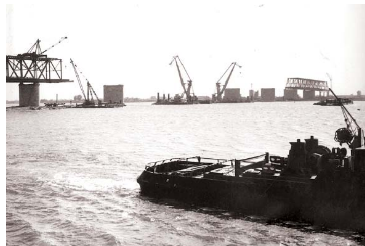
Работы на мосту с правого берега реки Бузан
