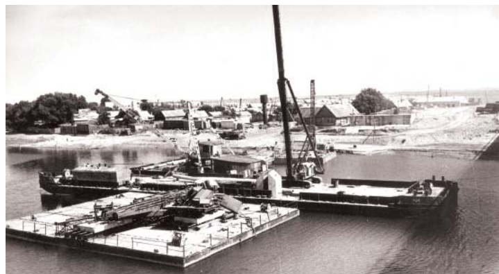
Забивка свай под опоры моста
