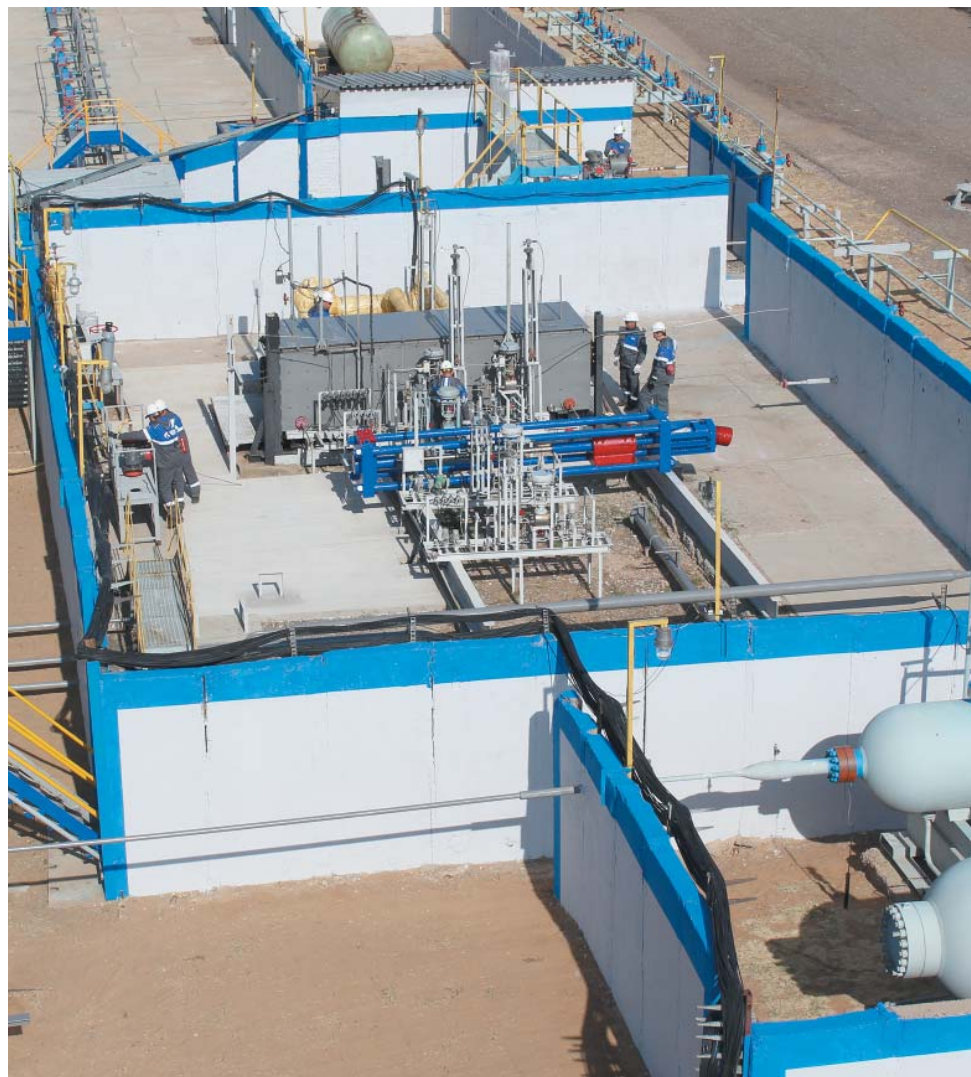
Участок опытного полигона
