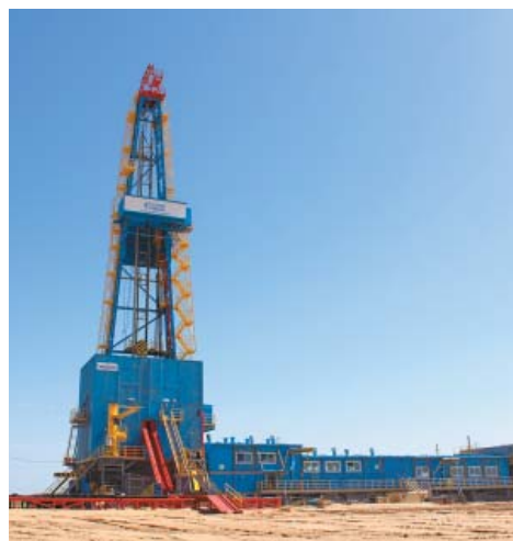
Буровая установка на скважине
