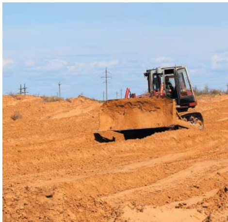
Подготовительный этап: земляные работы
