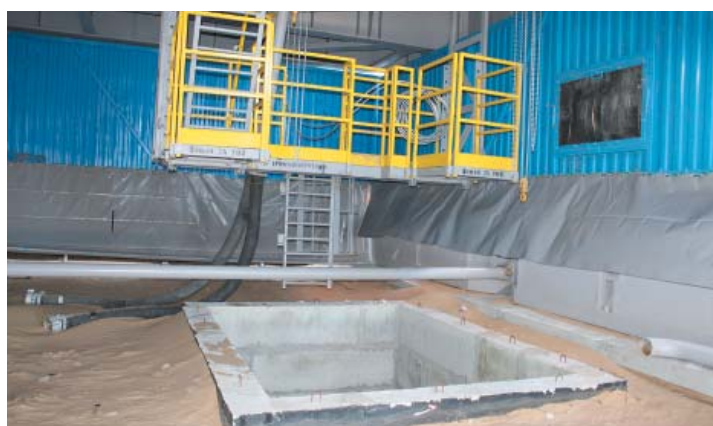
Устье скважины, подготовленное к процессу бурения
