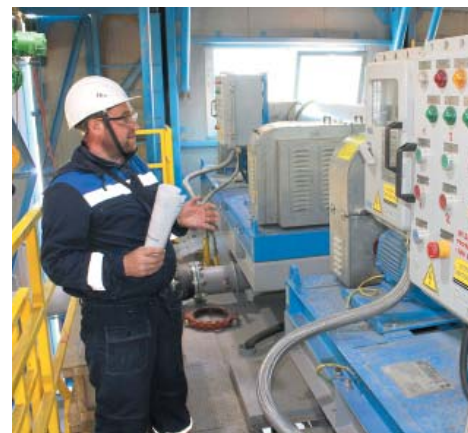
Виктор Картонов на модуле системы очистки
