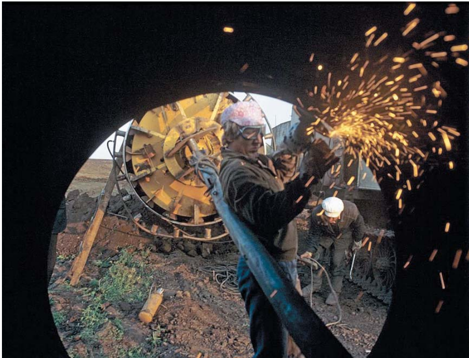
Трудовые будни строителей. Фото РИА «Новости»
