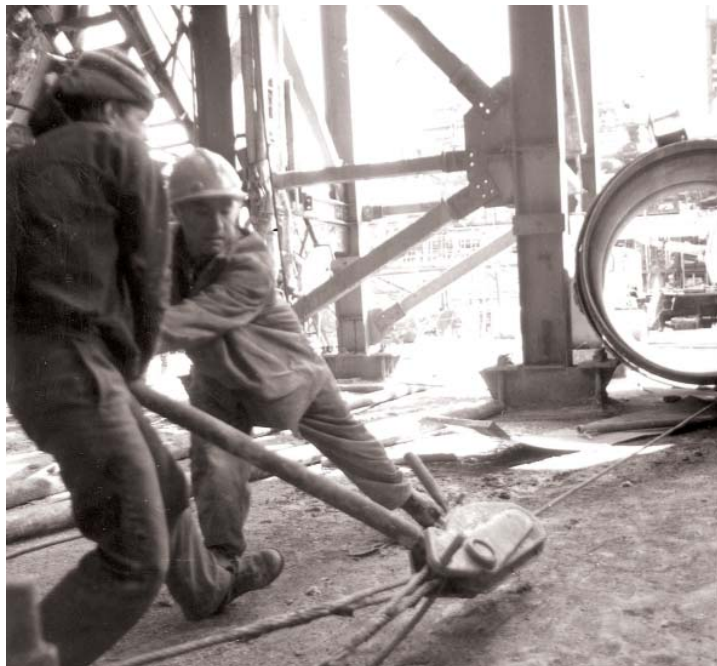
Монтаж оборудования. 1980-е гг.
