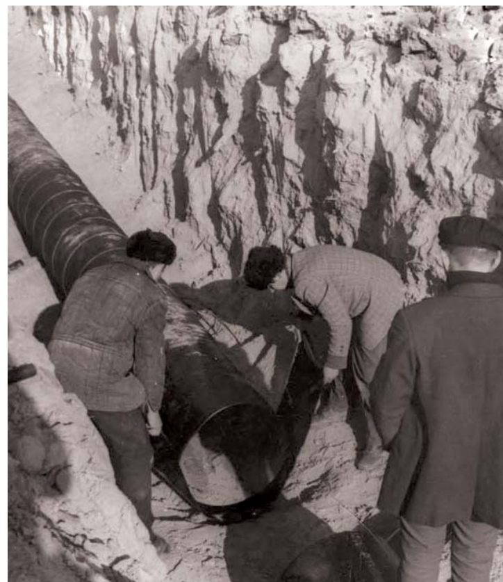
Изоляция трубопровода, 1983 г.
