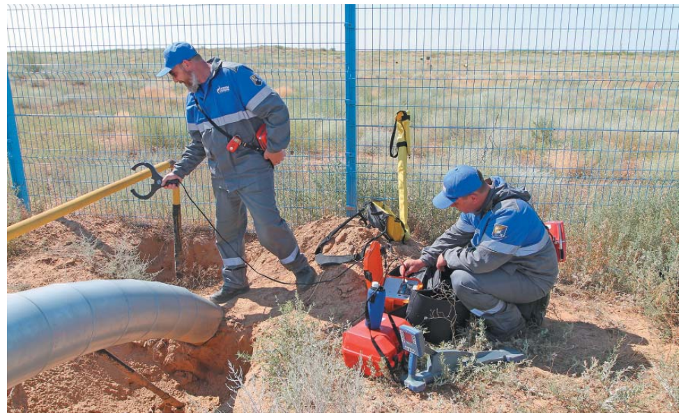
Подключение трассопоискового оборудования
