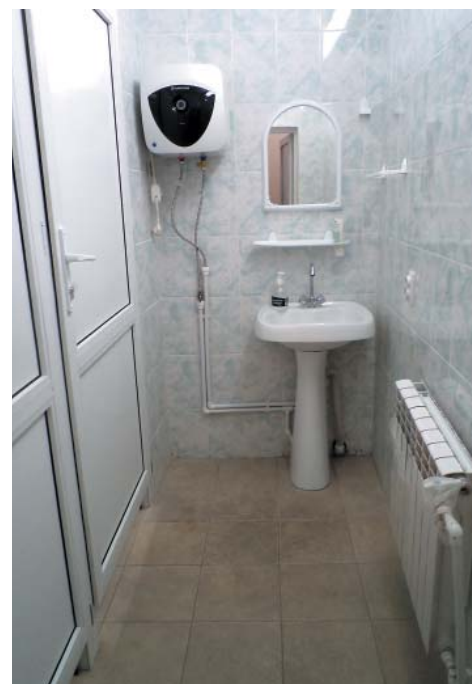
Санузел в Газопромышленном управлении
