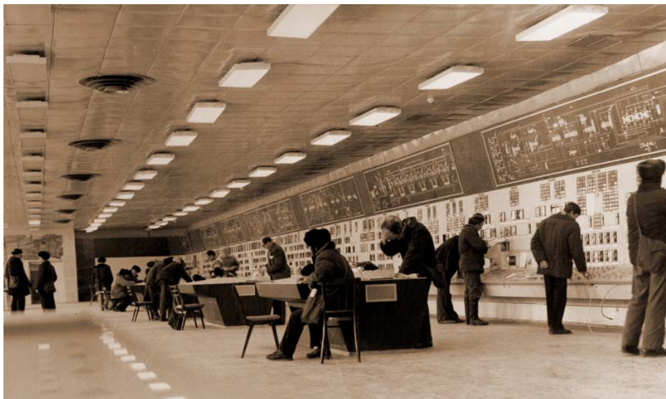
Операторная первой очереди завода, 1987 г.
