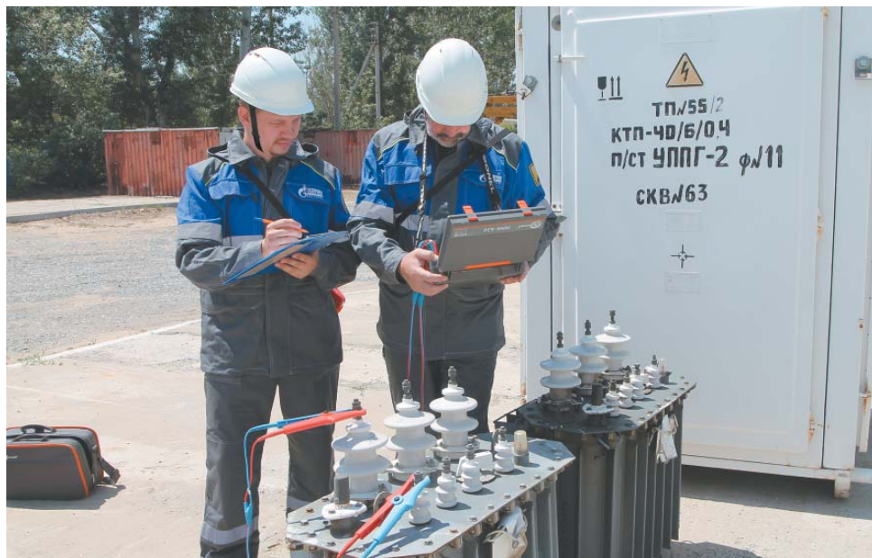
Проведение измерений на трансформаторе ТМГ
