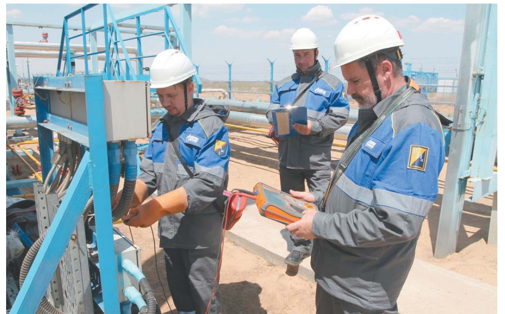
Измерение сопротивления изоляции кабельной линии проводят сотрудники ЭТЛ ГПУ
