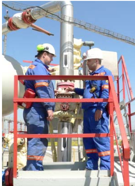
Старший оператор Вадим Темирханов показывает последовательность технологических операций по замене диафрагмы на узле замера расхода газа контрольного сепаратора
