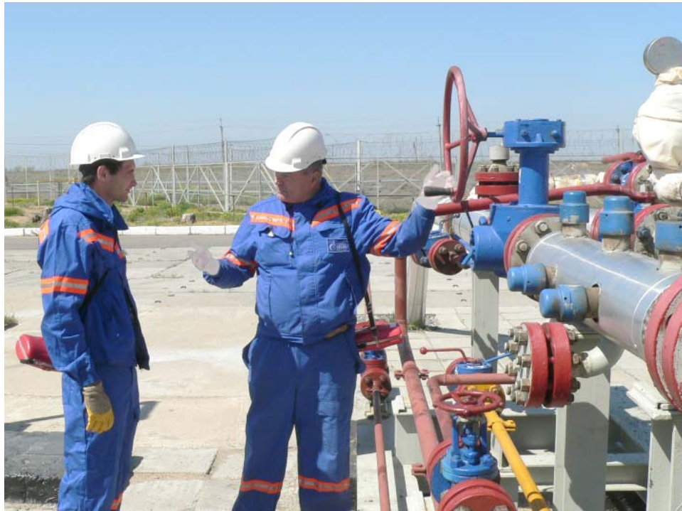
Наставник старший оператор Александр Овчинников объясняет оператору Георгию Тихоненко принцип работы узла запуска очистных поршней
