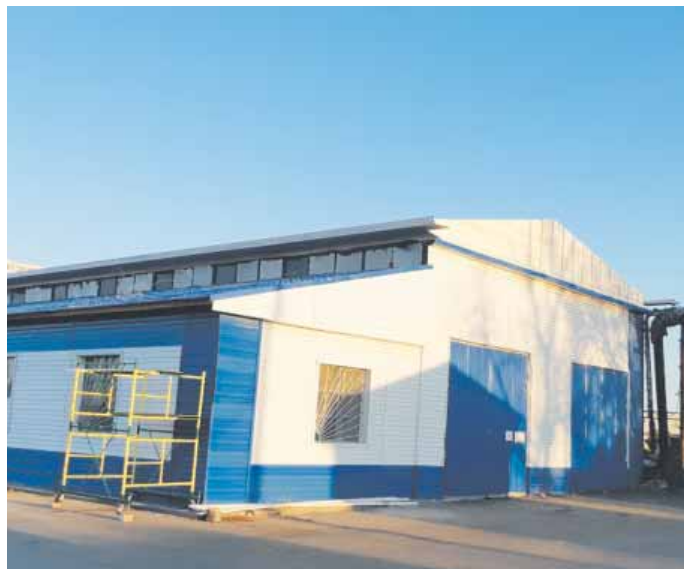
В столярной мастерской проводится восстановительный ремонт кровли
