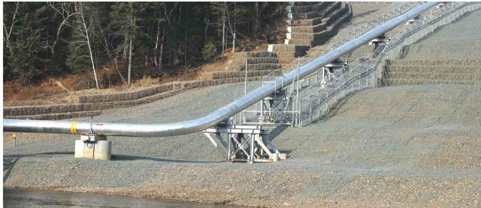
Укрепление поверхности береговых участков газопровода «Сила Сибири»
