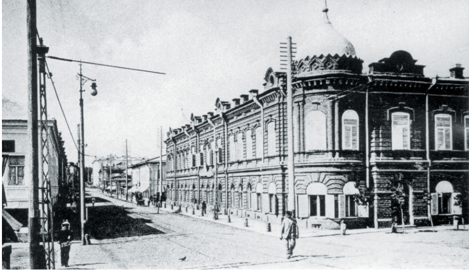
Доходный дом купцов Сергеевых ныне одно из офисных зданий ООО «Газпром добыча Астрахань»
