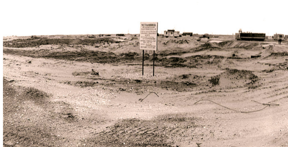
Начало строительства УППГ-4, 1989 год
