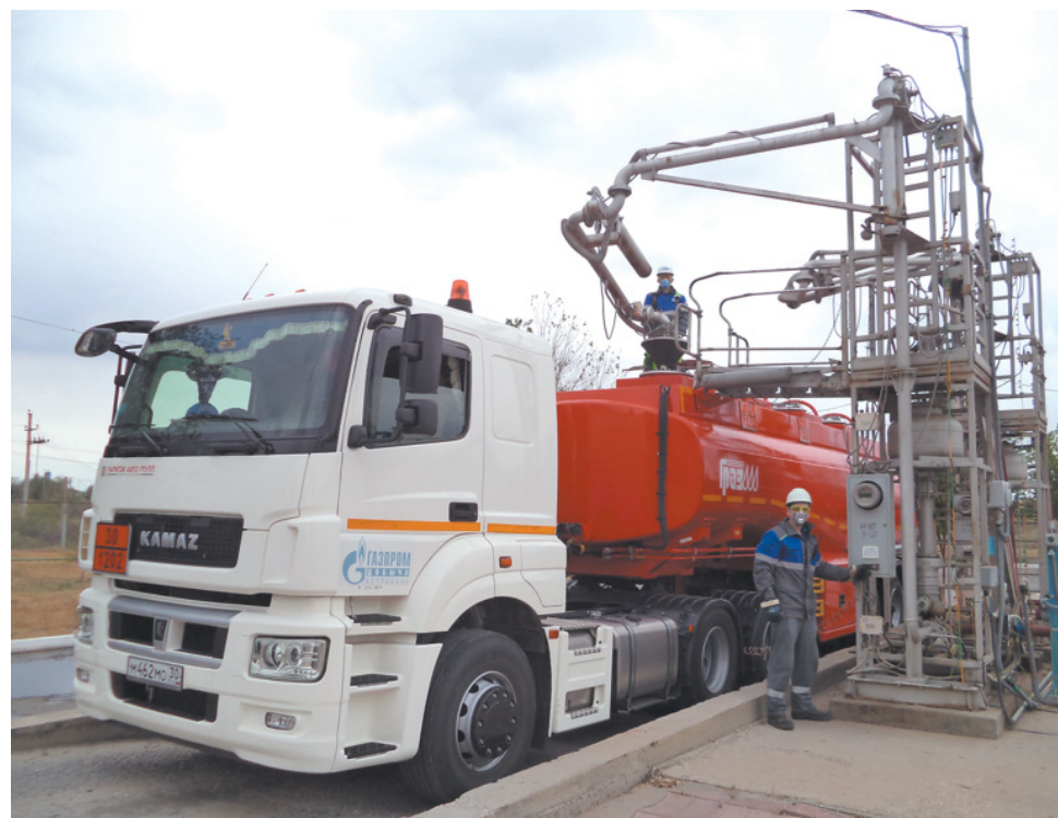
Налив раствора ингибитора коррозии в автоцистерну комплексом АСН-5ВГ
