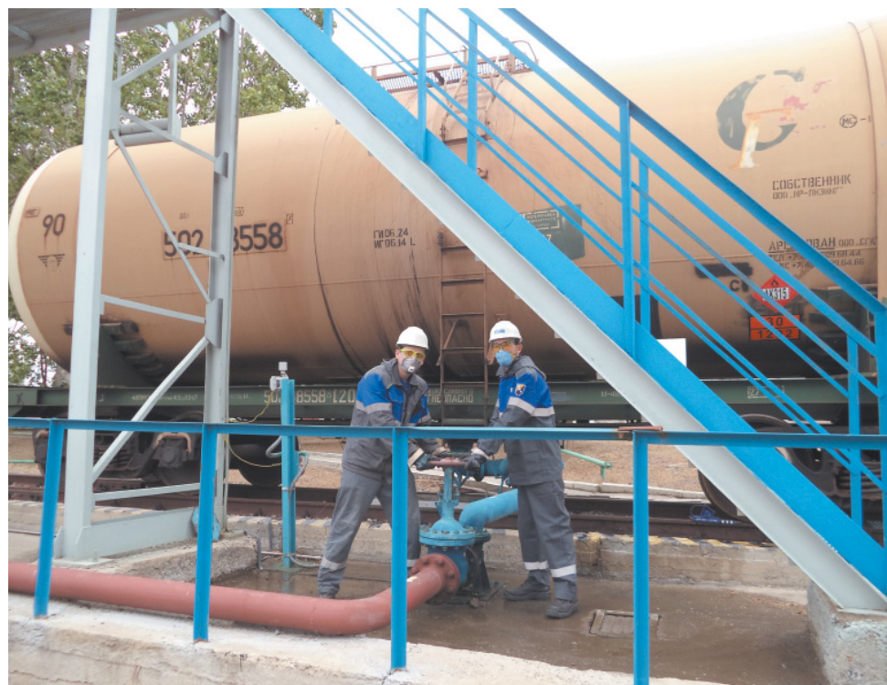
Слив дизельного топлива из ж/д цистерны установкой нижнего слива УСН-150
