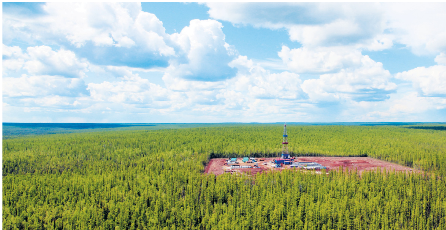
Бурение скважин на Ковыктинском месторождении
