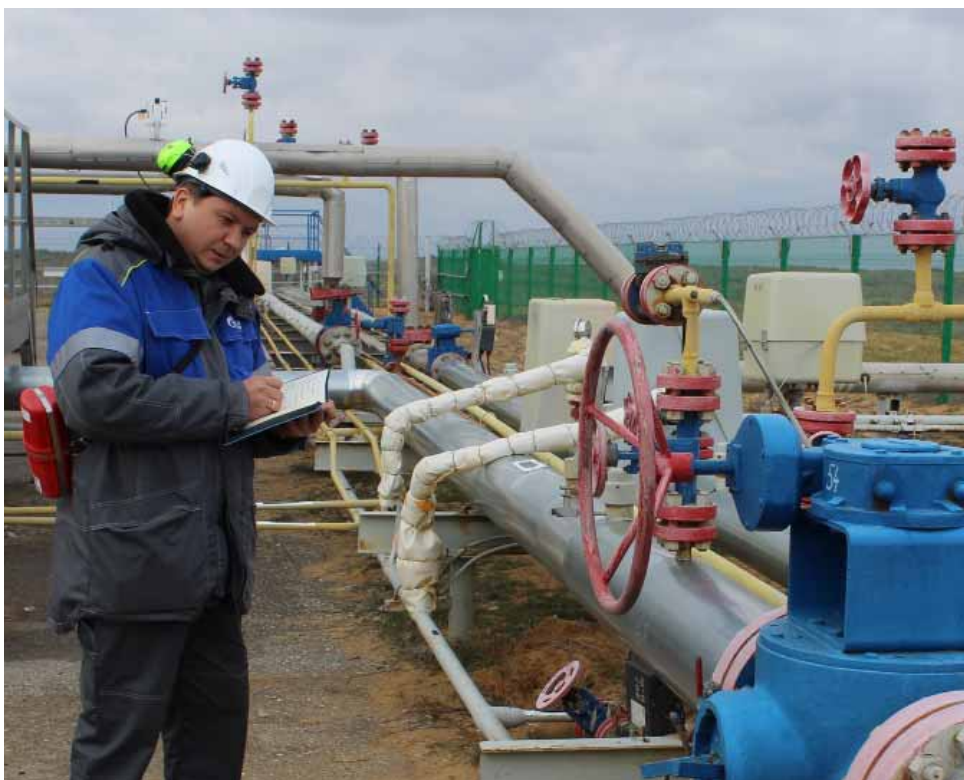
Заместитель начальника СТН Руслан Рамильевич Илалов проводит техническое освидетельствование технологических трубопроводов
