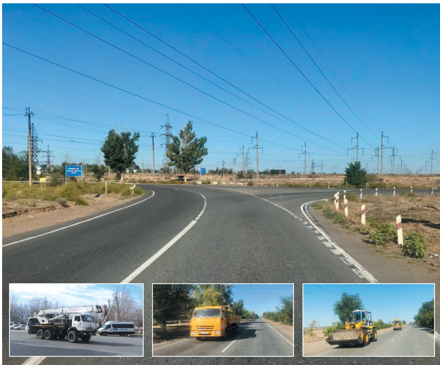
Общая протяженность дорог на Астраханском газоконденсатном месторождении – 240 километров
