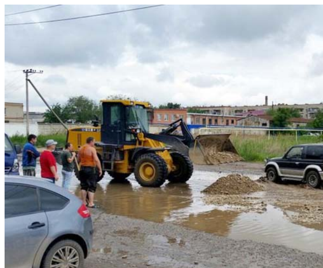
Предприниматели самостоятельно проводят ремонт дороги на ул. 5-й Керченская
