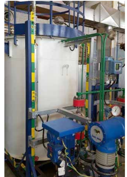
Блок дозирования реагентов
