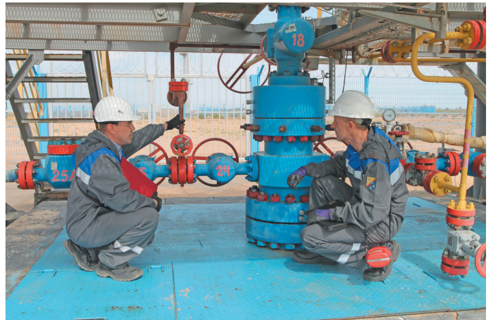
Контроль за выполнением диагностических работ на трубной головке
