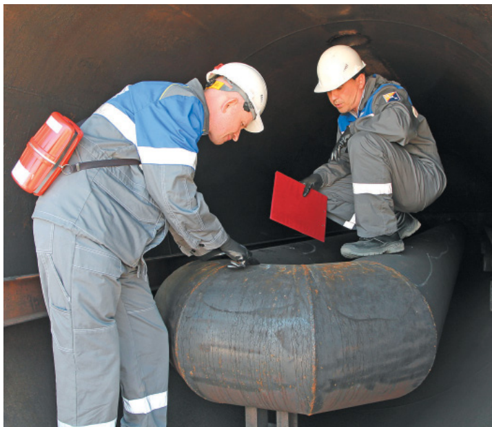
Контроль за выполнением диагностических работ на устьевом подогревателе
