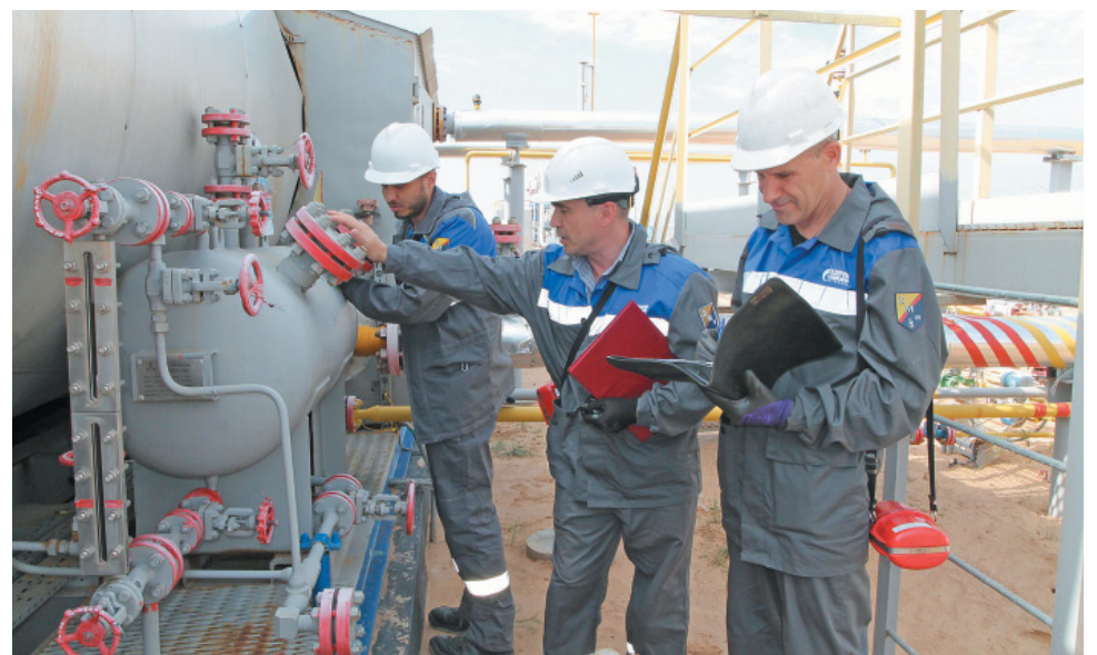
Контроль за выполнением диагностических работ на ёмкости хранения метанола в рамках экспертизы промышленной безопасности
