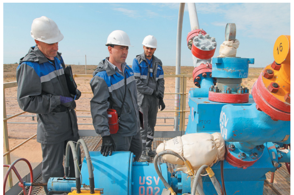
Контроль за выполнением диагностических работ на фонтанной арматуре
