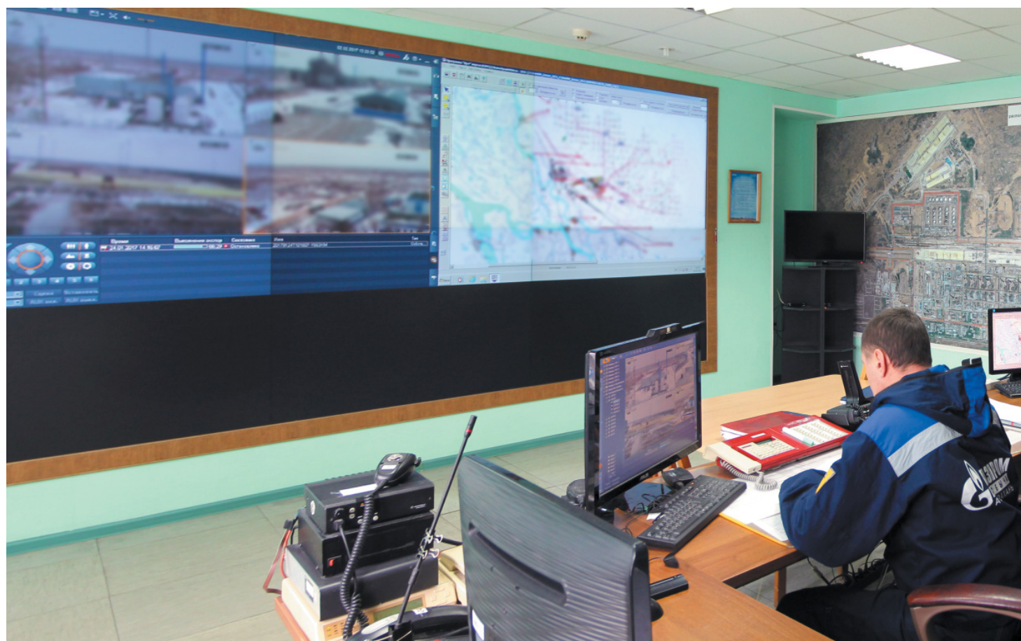
Центральный пост газовой безопасности (ЦПГБ) – центр мониторинга системы круглосуточного контроля за газовой безопасностью и принятия решений при газовой опасности на территории АГК.
