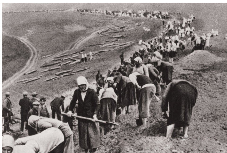
Строительство Астраханского обвода
