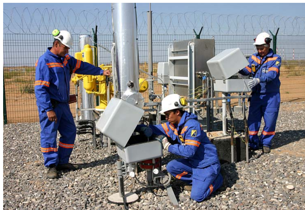
Операторы по добыче нефти и газа Линейно-эксплуатационной службы под руководством мастера проводят контрольный осмотр технологического оборудования (запорной арматуры, приборов КИПиА) на крановом узле № 6/6 газоконденсатопровода УППГ-6 – АГПЗ перед пуском УППГ-6 в работу по окончании ежегодного ППР
