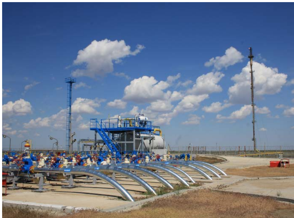
Операторы по добыче нефти и газа Линейно-эксплуатационной службы под руководством мастера проводят контрольный осмотр технологического оборудования (запорной арматуры, приборов КИПиА) на крановом узле № 6/6 газоконденсатопровода УППГ-6 – АГПЗ перед пуском УППГ-6 в работу по окончании ежегодного ППР
