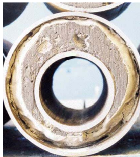
Образование трещин и каналов при некачественном цементном цементировании труб
