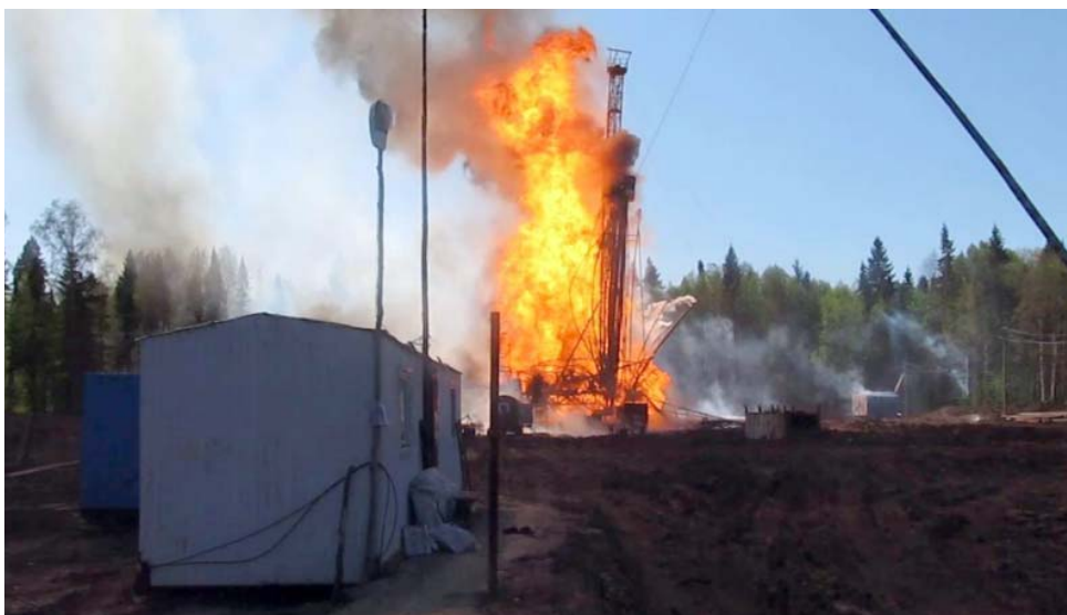
Неуправляемый фонтан на газовой скважине
