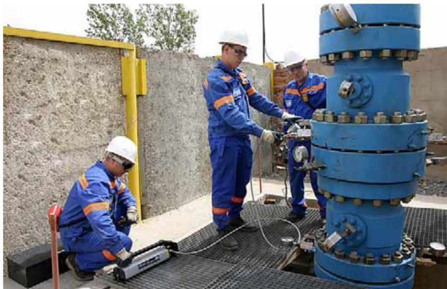
Опрессовка вторичного уплотнителя на обвязке колонны фирмы «Корвет»
