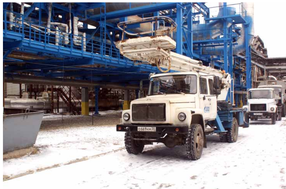
Проведение ремонтных работ и переключения трубопроводов на эстакадах
