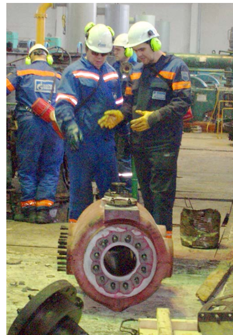
Слесари участка № 10 РМЦ занимаются сборкой поршневого компрессора и установкой новых цилиндров
