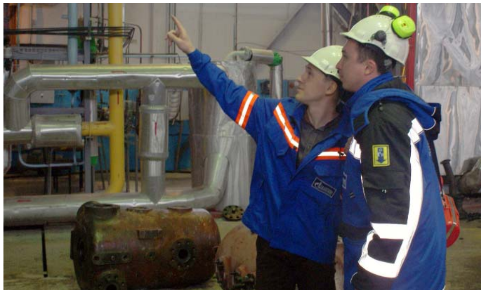
Начальник АКС Энвер Хабибулин и ведущий инженер цеха ТСиМЦК Сергей Бурмистров обсуждают мероприятия при подготовке к ремонту блока разделения воздуха
