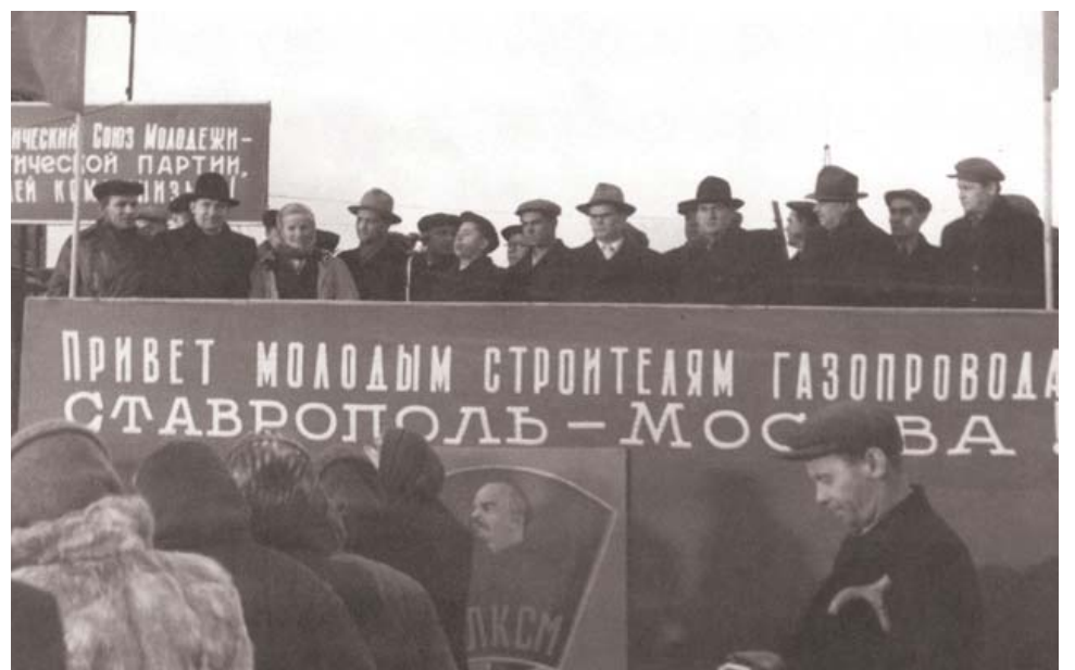
Строительство газопровода Ставрополь – Москва
