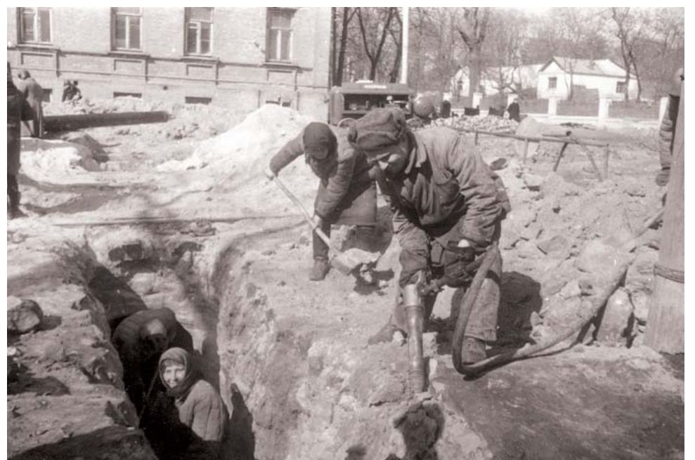
Строительство газопровода Дашава – Киев – Брянск – Москва
