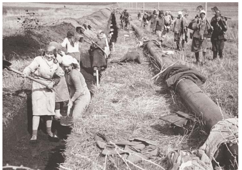
Строительство газопровода Саратов – Москва
